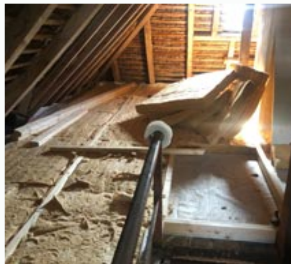
Dämmung des Dachbodens M41
