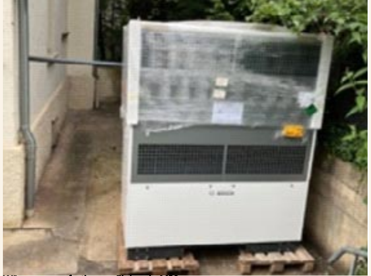
Wärmepumpe fertig zum Einbau in M39
